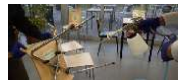
光触媒チタンコーティングの作業
