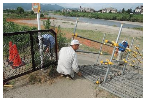
台風に備えた施設の固定作業
